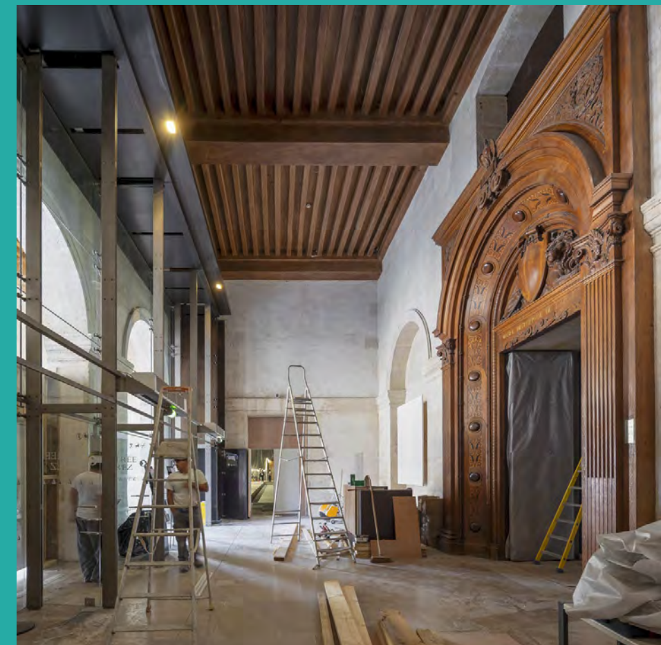
Travaux dans le futur accueil-billetterie
