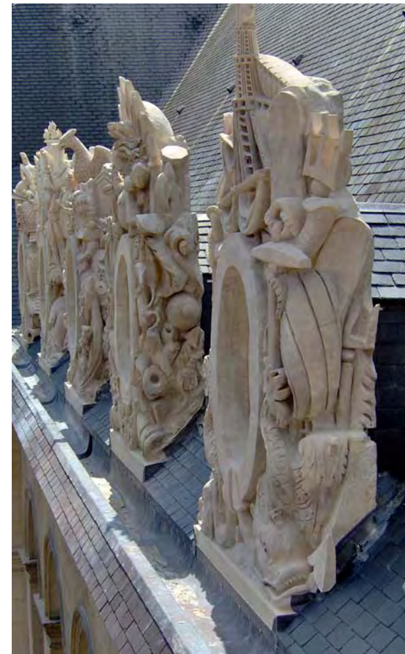
Vue des lucarnes et du pied de toiture après restauration. ©Benjamin Mouton ACMH
