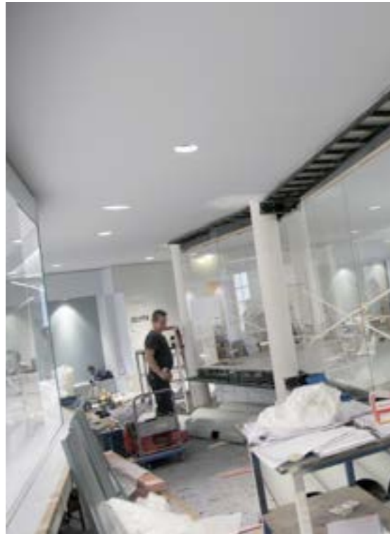
Les Cabinets insolites en travaux. © musée de l'Armée / Pascal Segrette
