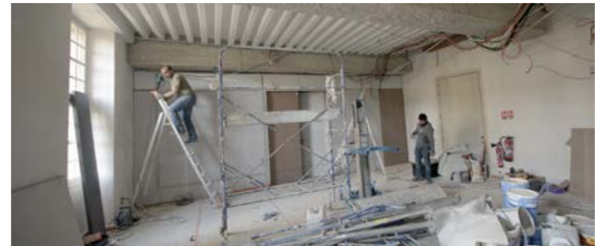
Les Cabinets insolites en travaux. © musée de l'Armée / Pascal Segrette
