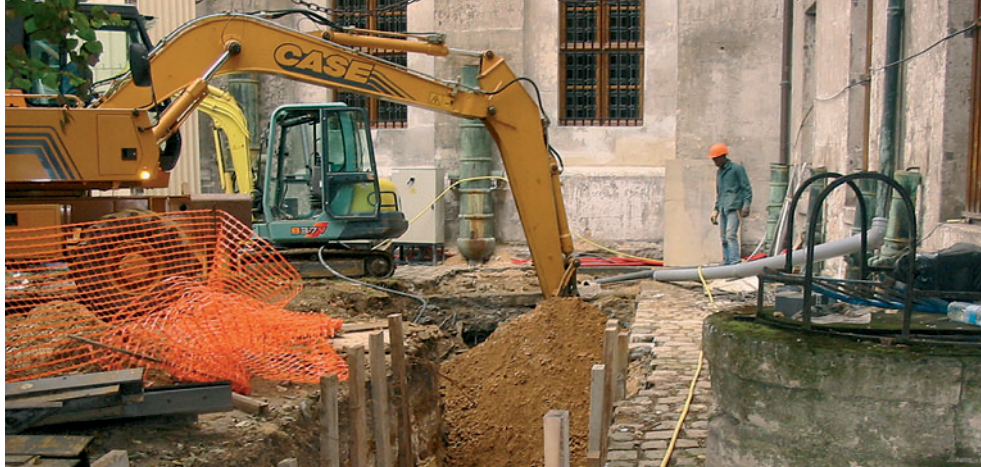
Création de caniveaux extérieurs pour le réseau de chauffage et de ventilation – Aile Occident.
